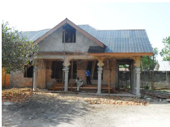
Le bâtiment d'accueil en construction
