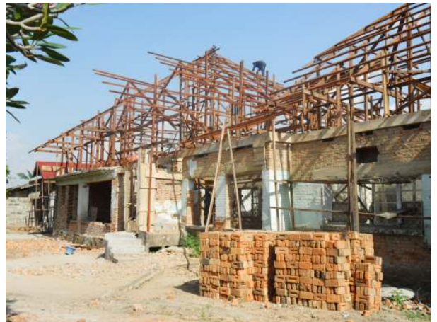
Le bâtiment en transformation
